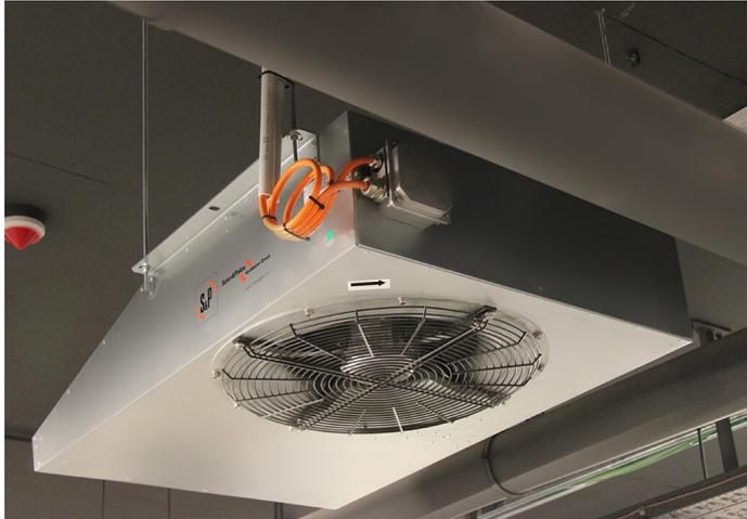
Les ventilateurs à jet ne nécessitent pas de conduits. Cela permet d'économiser de l'argent, d'obtenir un aspect plus propre avec moins de conflits, de réduire les exigences en matière de hauteur et de faciliter l'entretien.
